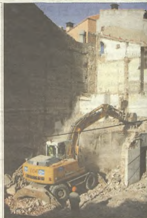
Derribo de casona tradicional en la Cuesta del Reloj, en la trasera del Ayuntamiento.
