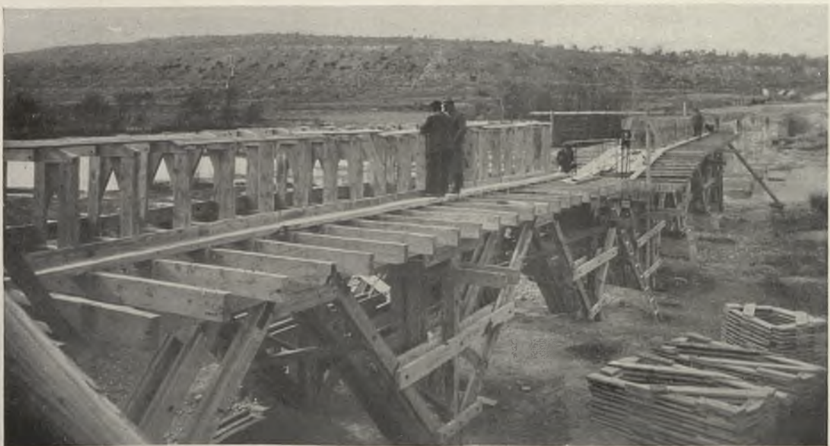
ARTESA DE SEGRE.—Encofrados y cinchas del puente.
