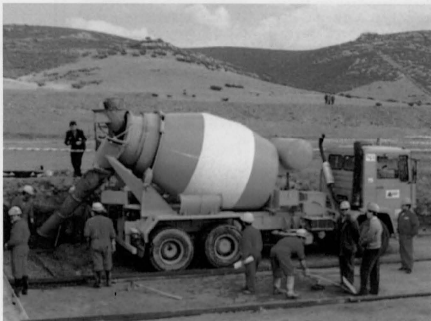
El 26 de octubre comenzaron los trabajos de cimentación del edificio que albergará la turbina de gas
