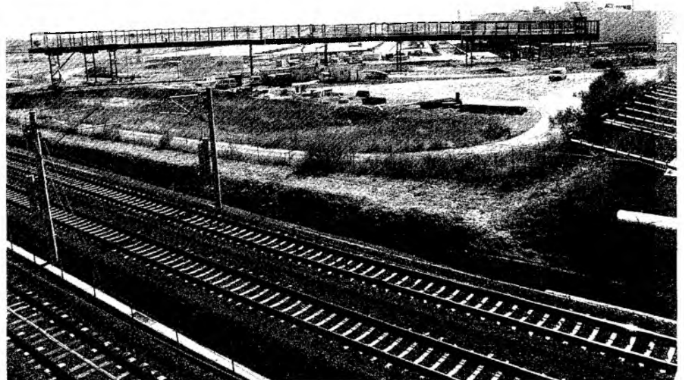
Pasarela que construye Anro en el Aeropuerto de Ciudad Real que servirá de acceso entre la terminal de pasajeros y el apeadero de trenes.
