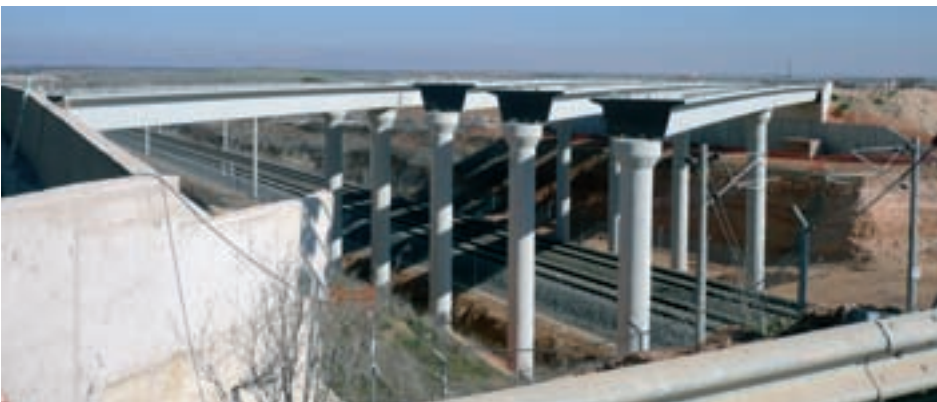
Puente sobre la vía del AVE, que atraviesa el parque.
