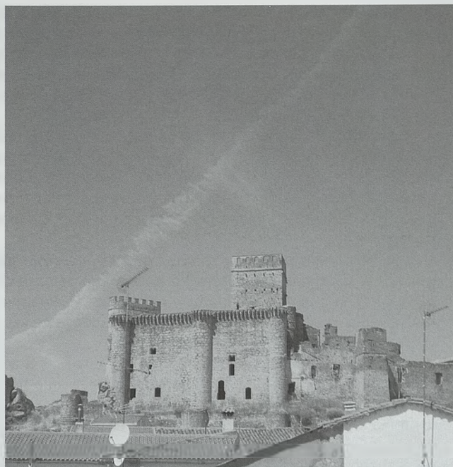
Fig. 3. Vista del castillo de Belvís de Monroy
