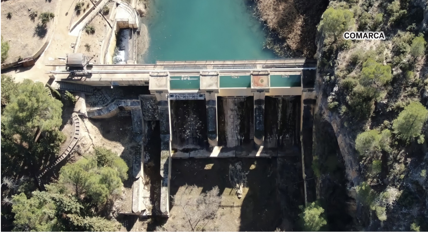
Presa de la toma
