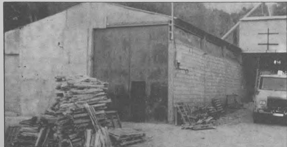
La serrería de Arguellite.
