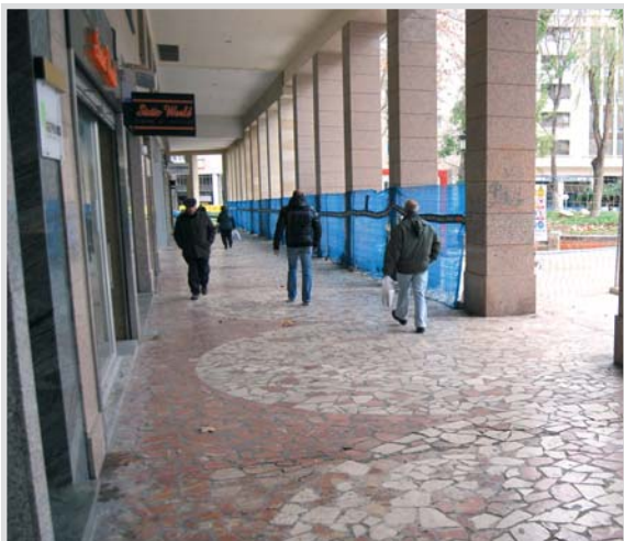
Soportales, que serán reformados.
