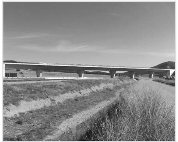
Una imagen del tramo Almansa-La Encina.
