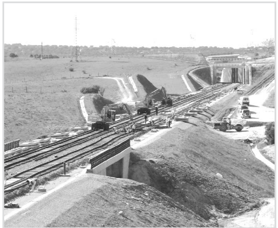
Adecuación de las vías a ancho internacional.
