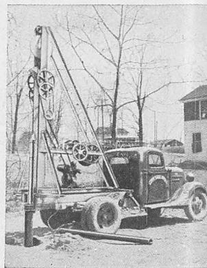
Perforadora pozos «Consol», para agua. Efectúa toda clase de perforaciones hondas y difíciles. El equipo se puede acoplar a un auto, por medio de un dispositivo especial.
