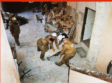
El Obispado recuperará su Claustro
