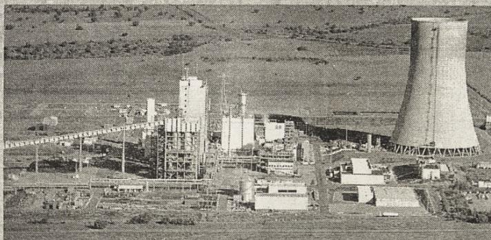
ELCOGÁS HA CONSTRUIDO EN PUERTOLLANO LA MAYOR CENTRAL ELÉCTRICA DEL MUNDO DE GASIFICACIÓN INTEGRADA EN CICLO COMBINADO (GICC), QUE DESARROLLA UN AVANZADO PROCESO DESTINADO A LA UTILIZACIÓN LIMPIA DE LOS CARBONES DE LA COMARCA.
